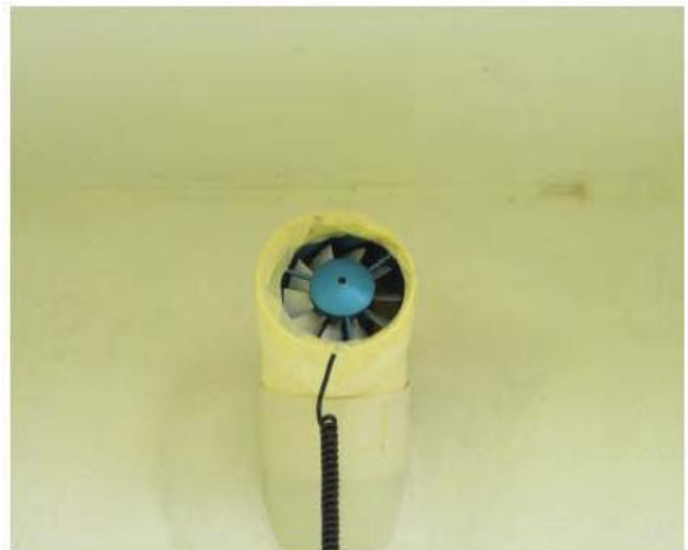
Fig. I.1-16: Misura della portata d'aria in uscita dalla cappa di cucina domestica
